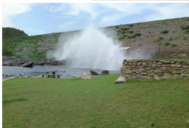
Foto 01: Vista de jusante para barragem. (Fonte: Google Earth)
