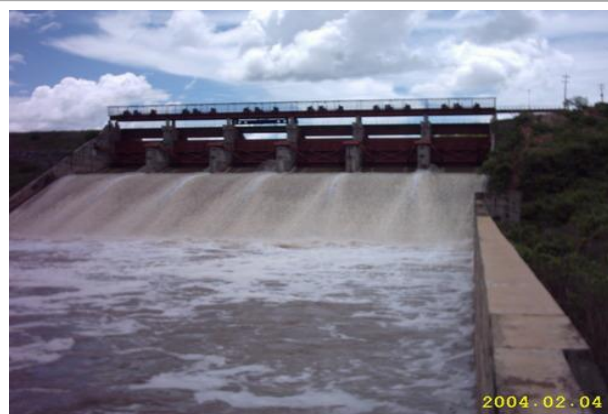
Foto 02: Vertedouro da barragem. (Fonte: Google Earth)
