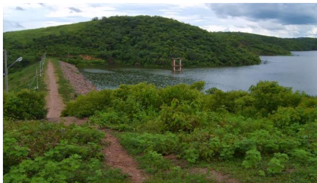
Foto 01: Vista lateral do corpo da barragem. (Fonte: http://dacadeirinhadearruar.blogspot.com.br/ )
