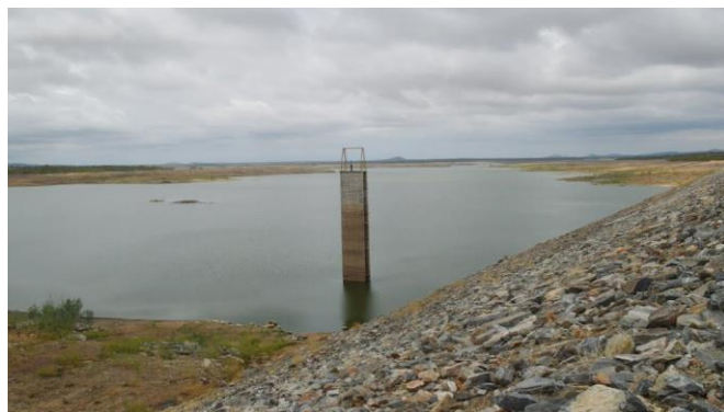
Foto 01: Vista da barragem para montante. (Fonte: Google Earth)
