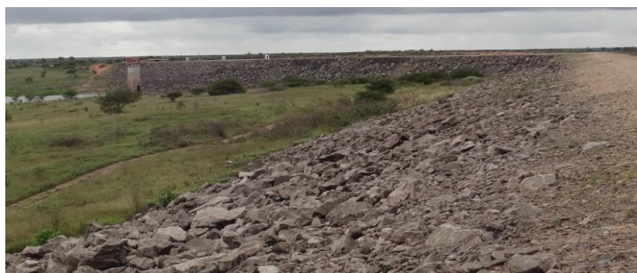
Foto 01: Paramento de montante da barragem.
