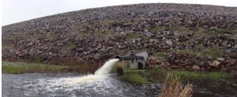
Foto 01: Vista de jusante para a barragem liberação para jusante.
