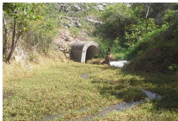
Foto 02: Registro gaveta da tomada d'água - liberação para jusante.
