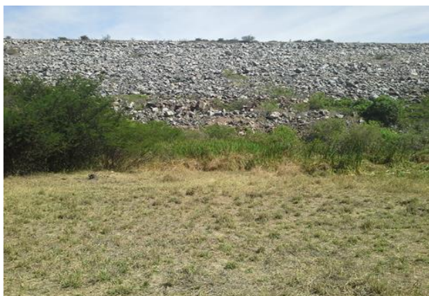
Foto 01: Detalhe do paramento de jusante.
