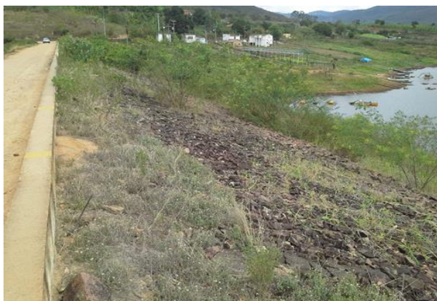
Foto 01: Detalhe do paramento de montante.
