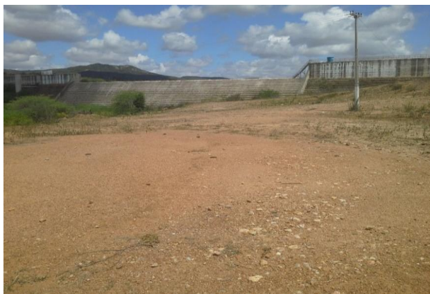
Foto 01: Vista de jusante para barragem.
