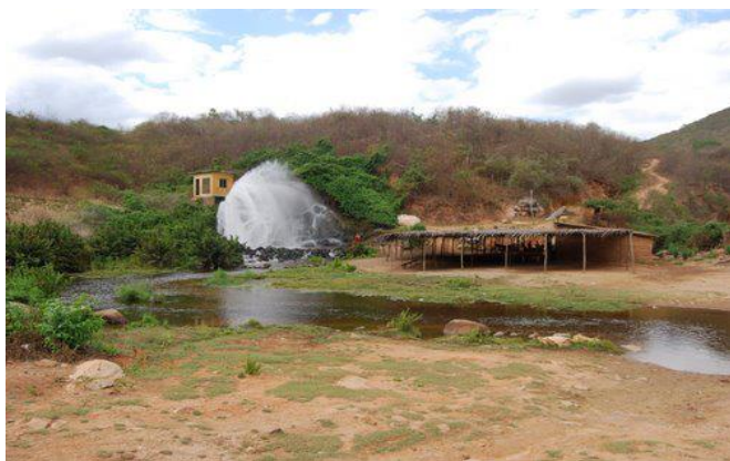
Foto 01: Vista de jusante para a barragem. (Fonte: Google Earth)
