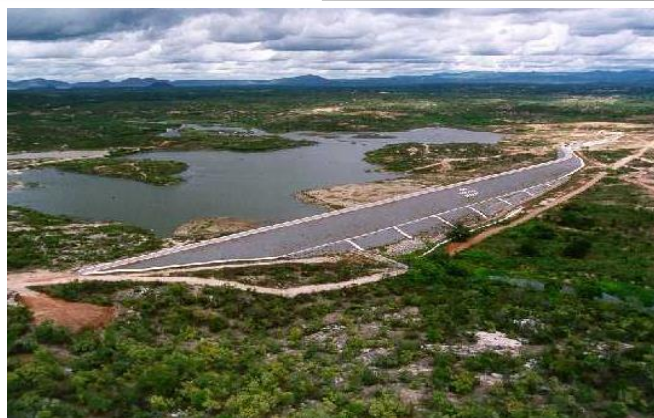
Foto 01: Vista aérea do corpo da barragem. (Fonte: http://atlas.srh.ce.gov.br/ )
