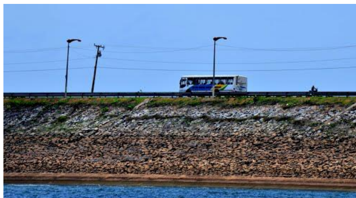
Foto 01: Detalhe do paramento de montante. (Fonte: Google Earth)
