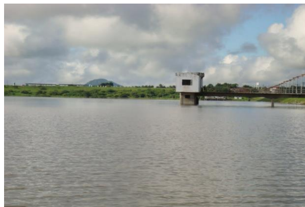
Foto 02: Torre de controle da tomada d'água. (Fonte: Google Earth)
