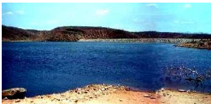
Foto 02: Vista de montante para a barragem. (Fonte: http://atlas.srh.ce.gov.br/ )
