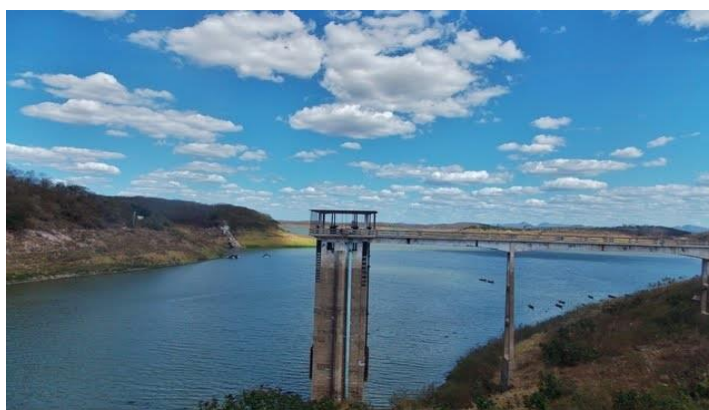
Foto 02: Torre de comando da tomada d'água. (Fonte: Google Earth)
