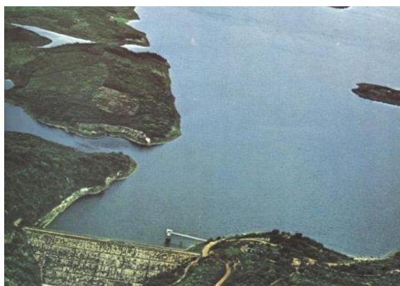
Foto 01: Vista aérea da barragem. (Fonte: http://atlas.srh.ce.gov.br/ )
