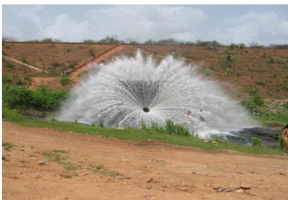
Foto 01: Vista de jusante para barragem - válvula dispersora. (Fonte: Google Earth)
