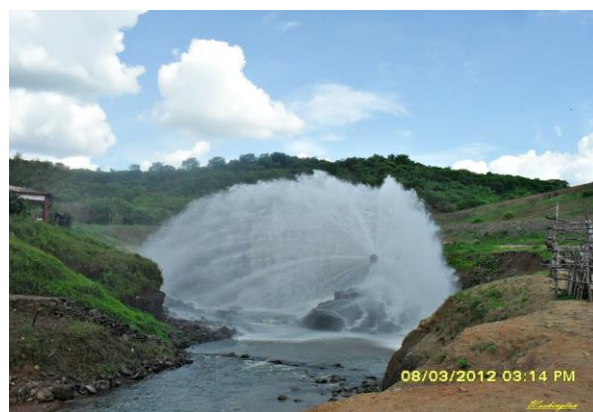
Foto 02: Liberação para jusante - válvula dispersora. (Fonte: Google Earth)
