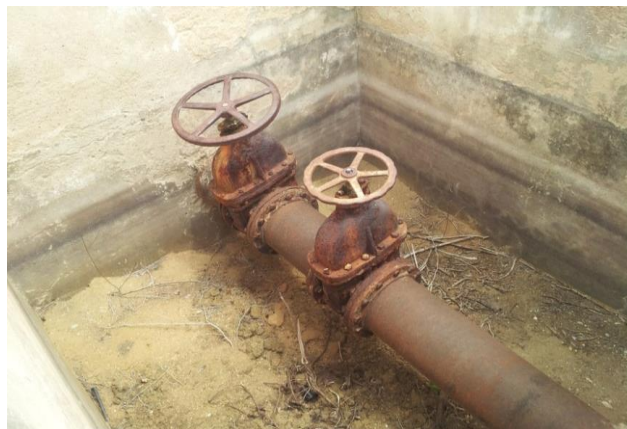
Foto 02: Tomada d'água: liberação de água para o leito do rio.
