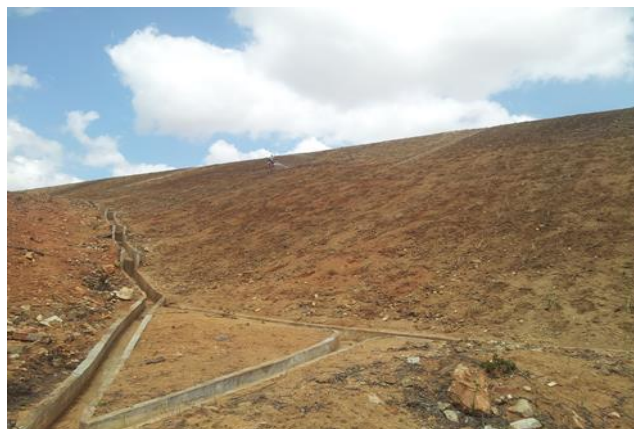
Foto 01: Paramento de jusante.
