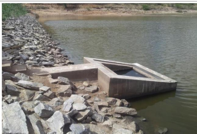
**Foto 02: Estrutura da tomada d'água a montante.**
