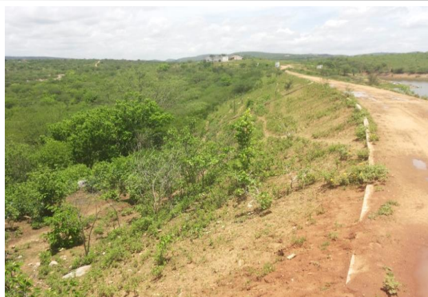
Foto 02: Detalhe do paramento de jusante.
