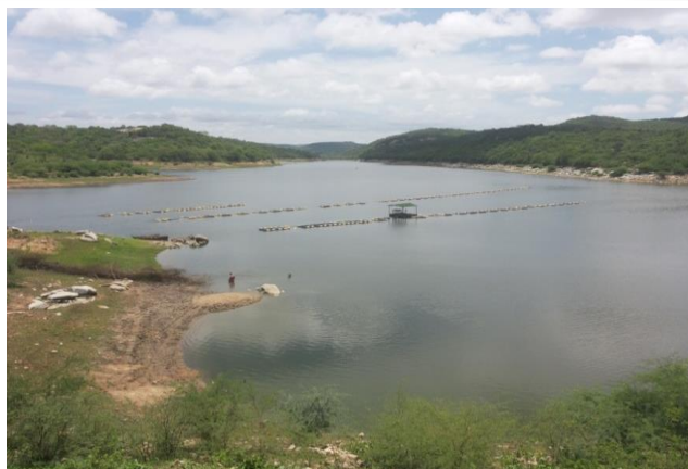
Foto 01: Vista da barragem para montante.
