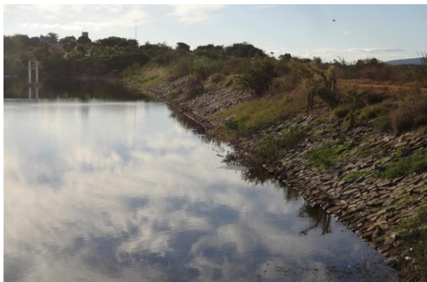
Foto 01: Vista de montante para a barragem - enrocamento no talude.
