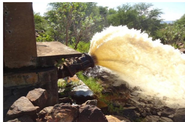
Foto 02: Liberação para jusante - válvula dispersora.
