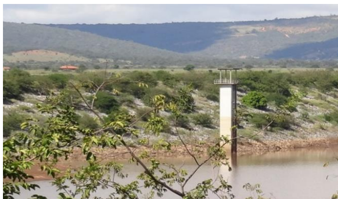
Foto 01: Vista de montante para a barragem.
