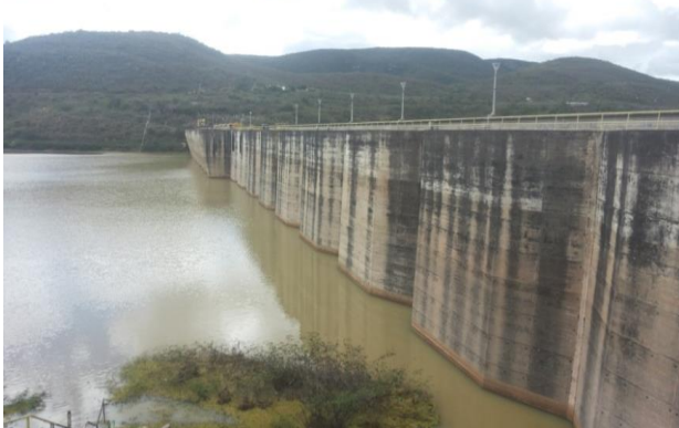
Foto 01: Vista de montante para barragem.
