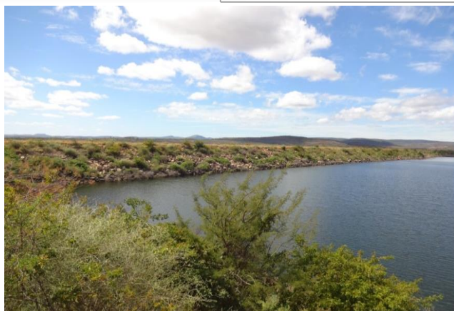
Foto 01: Paramento de montante.
