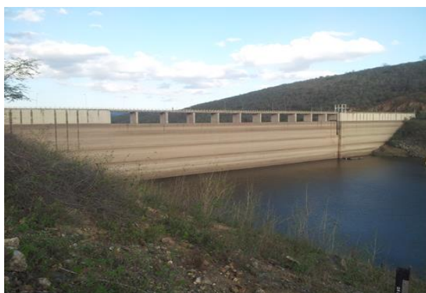
Foto 01: Vista de montante para barragem.
