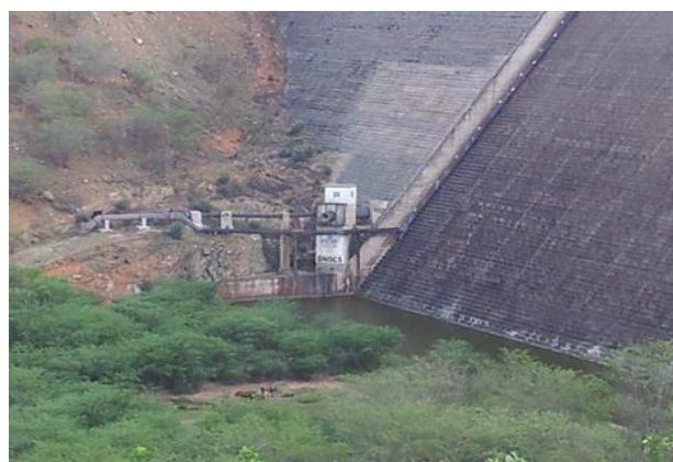
Foto 02: Tomada d'água a jusante - válvula dispersora.
