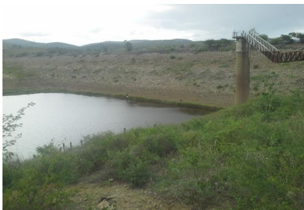
Foto 01: Vista de montante para barragem.
