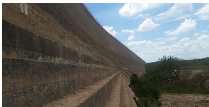
Foto 01: Detalhe do paramento de jusante.
