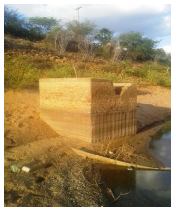
Foto 02: Tomada d'água a montante da barragem.
