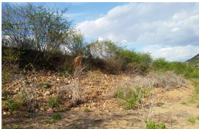
Foto 01: Paramento de montante.
