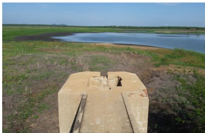
Foto 02: Torre de comando.
