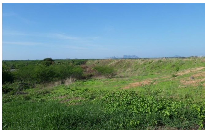
Foto 01: Vista da barragem a partir de jusante.
