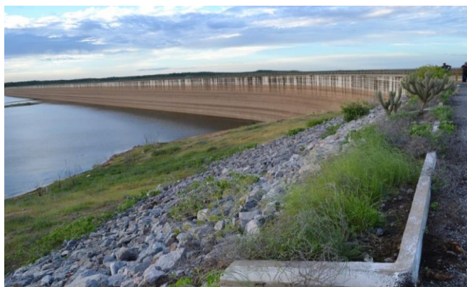
Foto 01: Vista da barragem auxiliar para a barragem principal.
