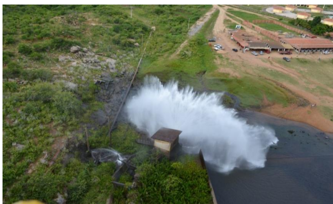
Foto 02: Tubulação da tomada d'água e válvula dispersora.
