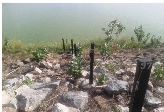
Foto 02: Conjunto de réguas no paramento de montante.
