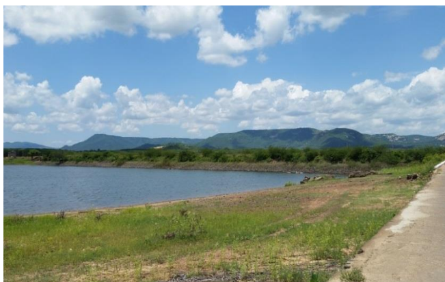
Foto 01: Vista da barragem a partir de montante.
