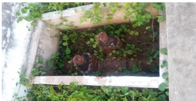
Foto 02: Registros da tomada d'água.
