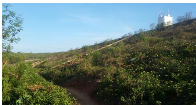
Foto 01: Detalhe do paramento de jusante.
