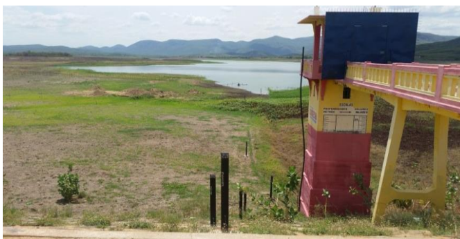
Foto 02: Réguas linimétricas e torre de comando.
