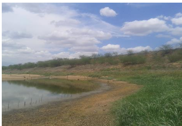
Foto 01: Vista de montante para barragem.
