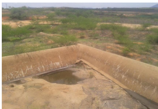
Foto 02: Ponte vertedoura - Perfil Creager.
