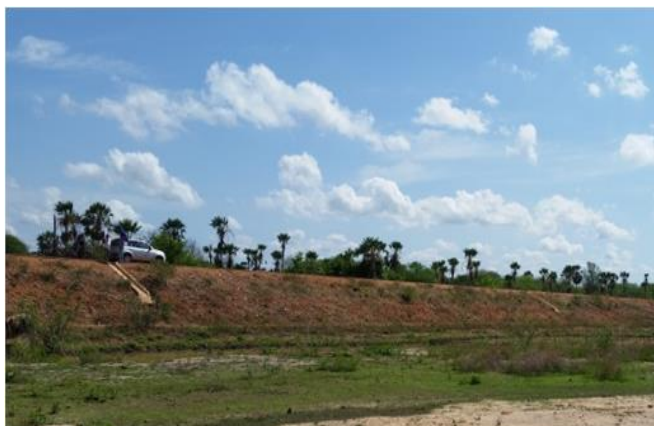
Foto 01: Vista de montante para barragem.
