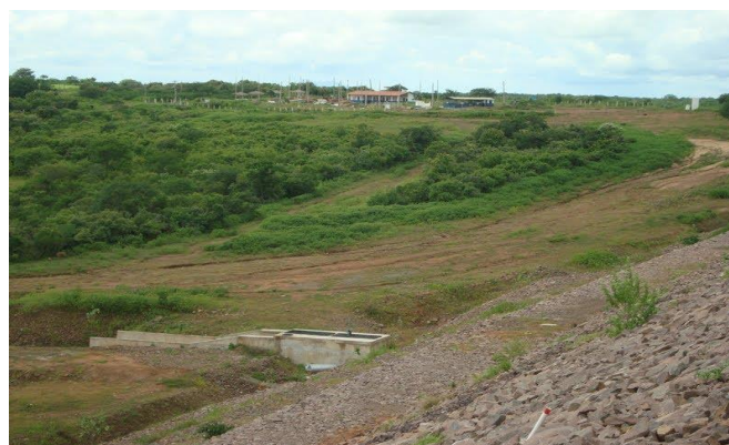
Foto 02: Detalhe da tomada d'água a jusante. Fonte: Google Earth
