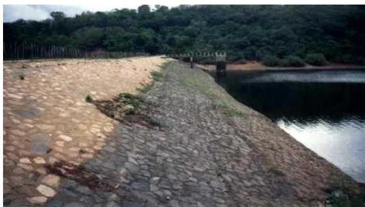
Foto 01: Detalhe do paramento de montante. (Fonte: Google Earth)
