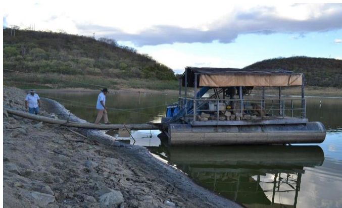
Foto 02: Detalhe de captação sobre flutuantes. (Fonte: http://jesusdacosta.blogspot.com.br/ )
