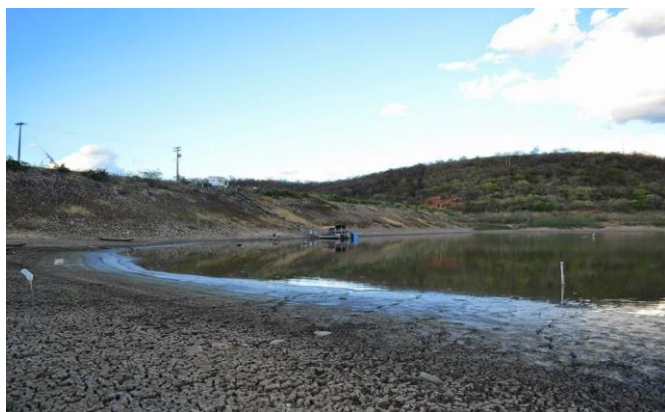
Foto 01: Vista de montante para barragem. (Fonte: http://jesusdacosta.blogspot.com.br/ )
