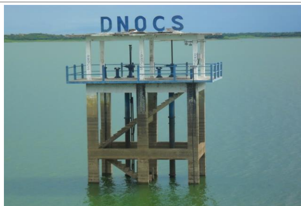
Foto 02: Detalhe da torre de comando da tomada d'água. Fonte: Google Earth
